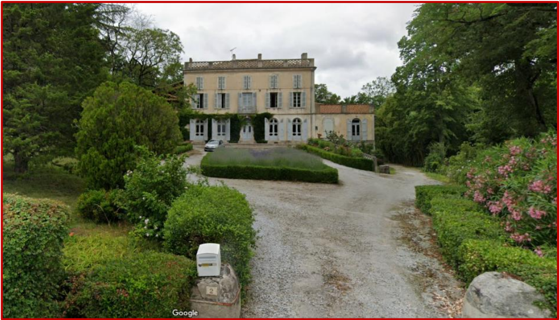
Vue de la façade principale depuis l'entrée de la propriété
