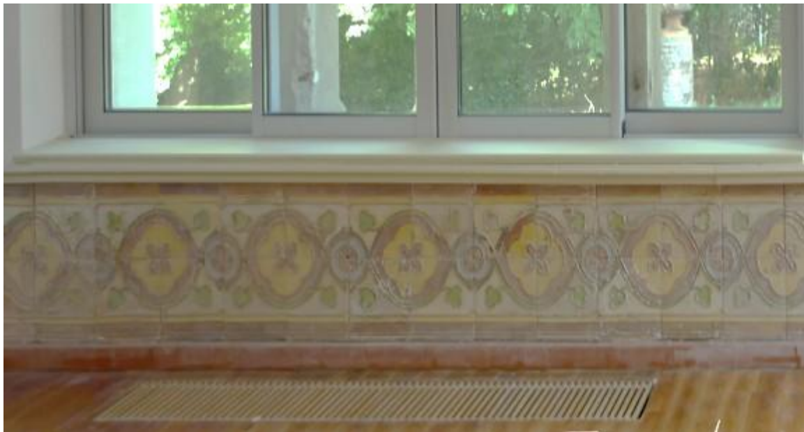
Allège en carreaux émaillés poursuivie en soubassement de ceinture de la pièce de séjour
