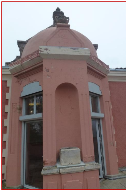
Sur façade niche à la statue dérobée
